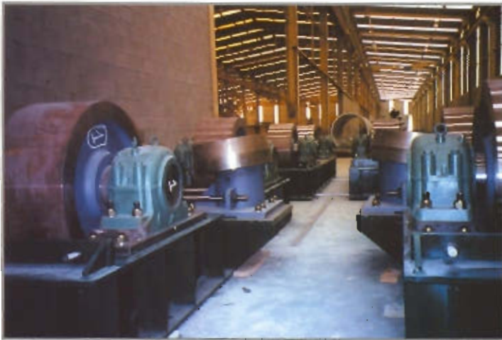
Roulements en Atelier pour expédition INSTALLATION ABOCOL-COLOMBIE
