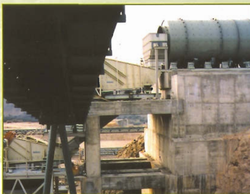
Instalación de Lavador y clasificación de Uranio. ENUSA-SALAMANCA-ESPAÑA.
