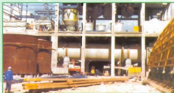
Granulación - SIAPE - GABES (TÚNEZ)
