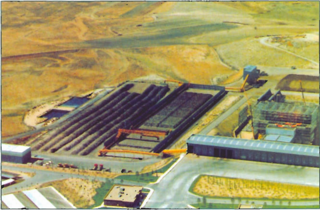
Parque de fermentación automático-compostaje-KOCH-ESPAÑA Planta de Valdemingómez, Cliente: Dragados Madrid (ESPAÑA)
