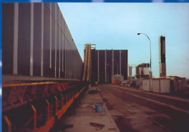
Vista general de las cintas de alimentación a caldera. Al fondo puede verse la incineradora, el sistema de tratamiento de gases y las chimeneas.
