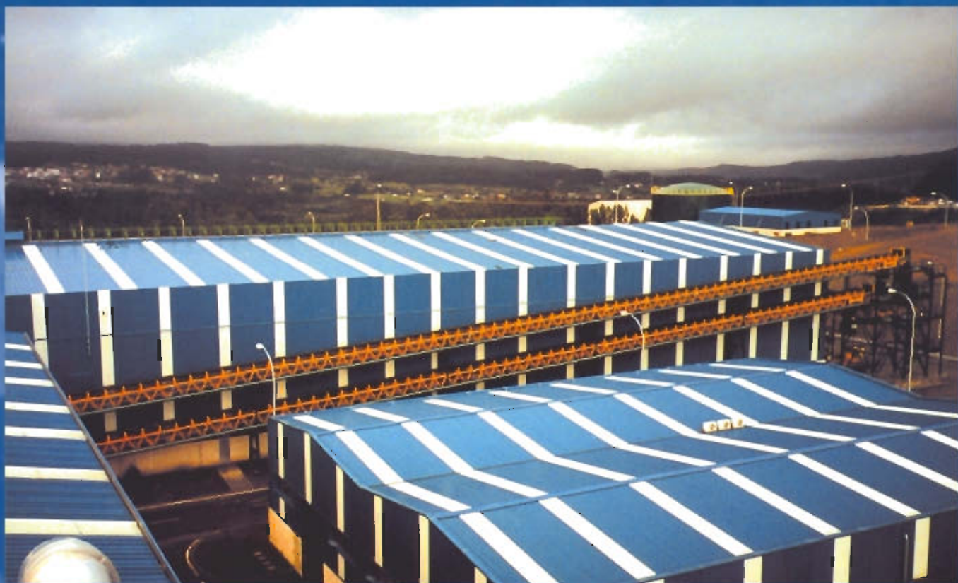
Vista parcial del Complejo Medioambiental de Cerceda. A Coruña (España).
