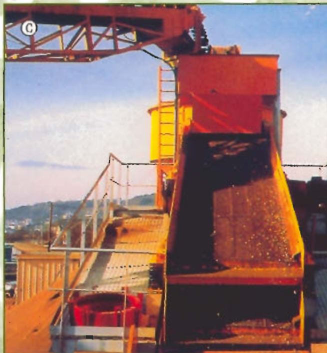
Installation complète criblage en carrière Débit 600 T/h Calcaire - Dibar - TURQUIE
