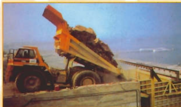
Décharge de dumpers 100 t de 0-2000 mm Installation Port-Bilbao - ESPAGNE
