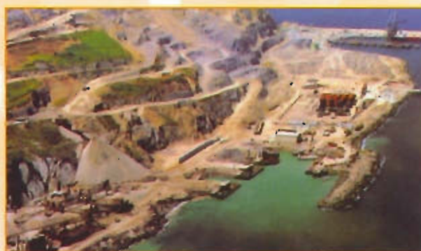
Installation Carrière - Ciervana - BILBAO
