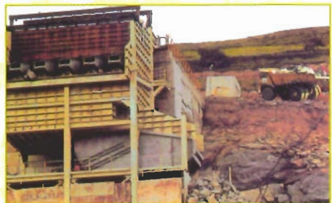
Ensemble de Précribleur et de doigts vibrants. Classification d'enrochement - BILBAO - ESPAGNE
