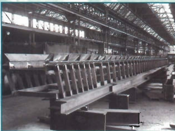
Fundición Alta Temperatura - FUCHOSA - ESPAÑA
