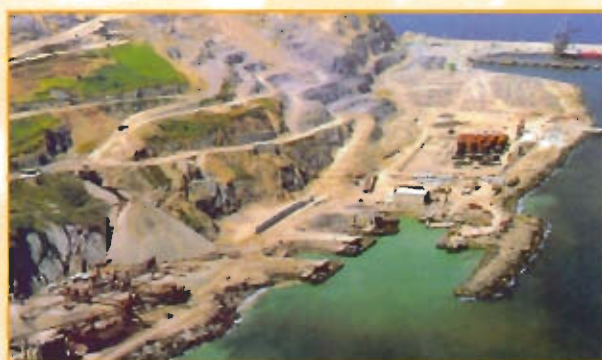
Instalación Puerto-cantera Ciervana - ESPAÑA
