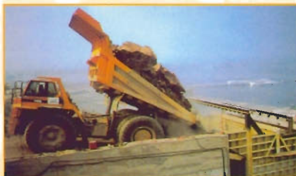
DESCARGA DE DUMPER (100 t) de un 0 - 2.000 mm Instalación Puerto BILBAO - ESPAÑA
