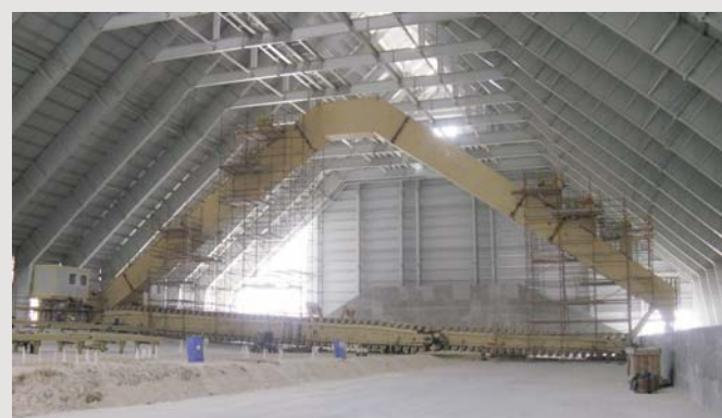
Portique racleur du parc de stockage couvert de phosphate et d'aditifs de 21.300 m 2 et 160.000 T pour tout le complexe chimique de Ras Az Zawr. Client: MA'ADEN/WORLEY PARSONS (Arabie Saoudite). Ingénierie: LITWIN.
