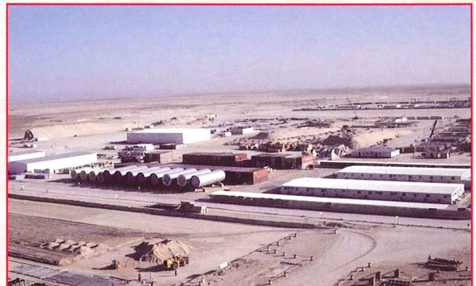
Cuatro Tambores Secadores, DAP/MAP, \varnothing 4,75 x 35,2 m, 650 T/h. Ma'aden/Worley Parsons (Arabia Saudita).
