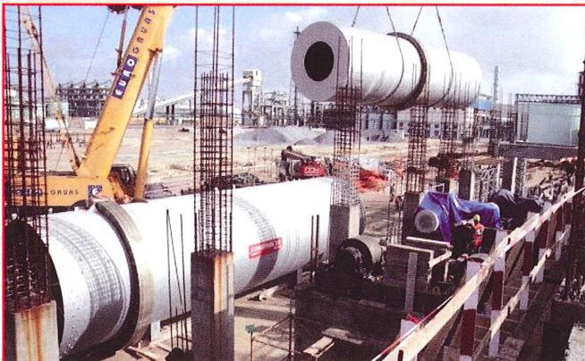
Dos Tambores Secadores, TSP/MAP/DAP, \varnothing 4 x 30 m, 375 T/h. BMP Bunge Maroc Phosphore (Marruecos).
