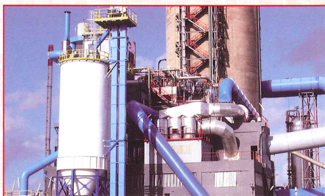
Silo y elevador de cangilones, dolomita. Ferial (Annaba, Argelia).
