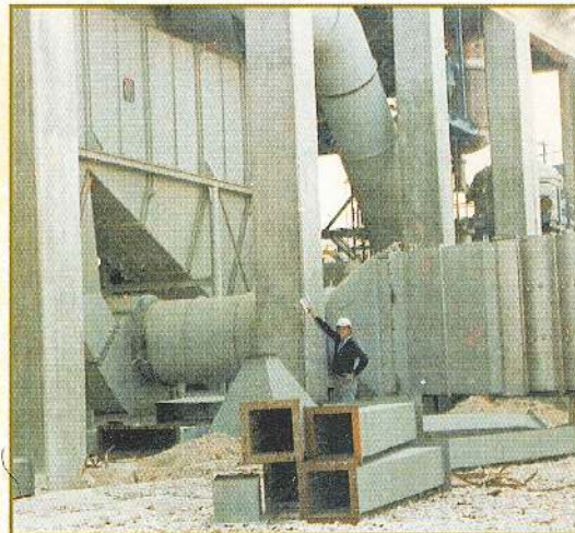
Lit Fluidisé Statique-Refroidissement Urée Client: Enfersa Espagne
