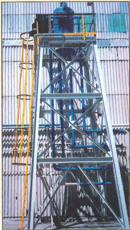
Refroidissement en Circuit d'Ammoniac (ouvert)
