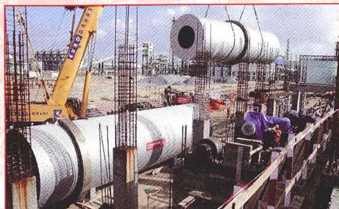
Deux tambours sécheurs, TSP/MAP/DAP, \varnothing 4 x 30 m, 375 T/h. BMP Bunge Maroc Phosphore (Maroc).
