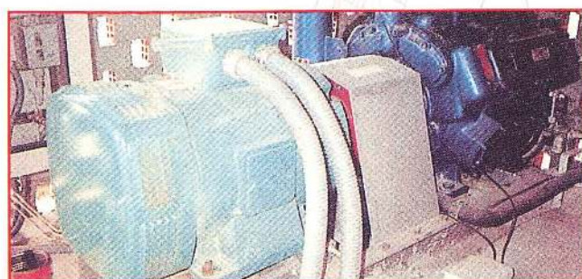
Compresseur pour unité de conditionnement en circuit de fréon, 600.000 frig/h. National Fertilizer Company. NPK (Taiwan).
