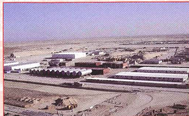
Quatre Tambours Sécheurs, DAP/MAP, \varnothing 4,75 x 35,2 m, 650 T/h. Ma'aden/Worley Parsons (Arabie Saoudite).
